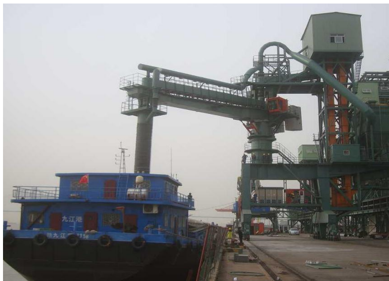
图 4 N-TGD2000 型钢丝胶带提升机现场照片
